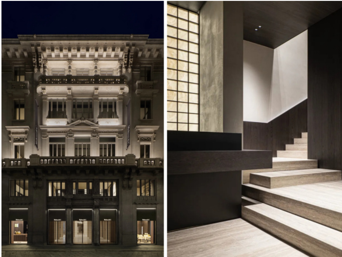
Palazzo Molteni, veduta della facciata neoclassico-liberty di Stefano Lissoni e Giuseppe Mentasti e uno scorcio degli interni ristrutturati da Vincent Van Duysen.
