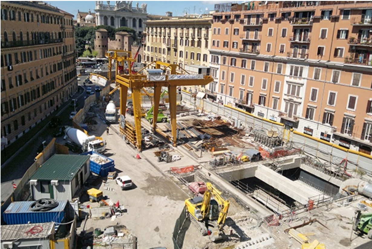
Roma, cantiere della Linea C
